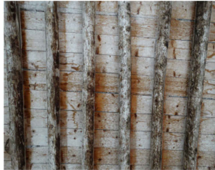
Μεταγενέστερο υλικό-Οροφή με βολίτζια σε ψάθα Οροφή με βολίτζια και σανίδια
