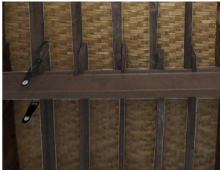
Μεταγενέστερο υλικό-Οροφή με βολίτζια σε ψάθα Οροφή με βολίτζια και σανίδια
